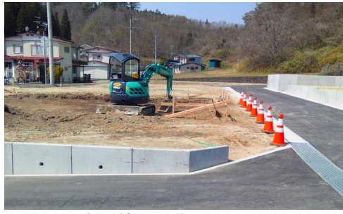
地盤強度の補強工事現場 山口跡地
