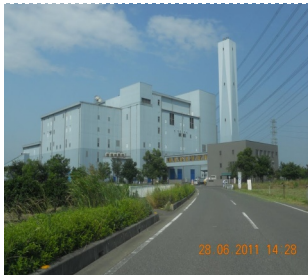
小山川クリーンセンター
