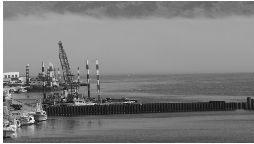
工事費大幅増、工期大幅延長の水門工事
