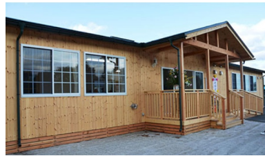
解体・廃棄された仮設保育所
