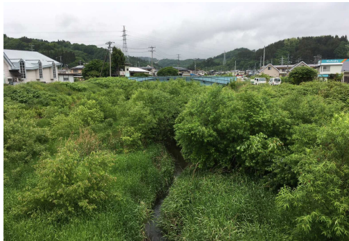
近内川の河川敷内に繁茂する樹木 (宮町)
